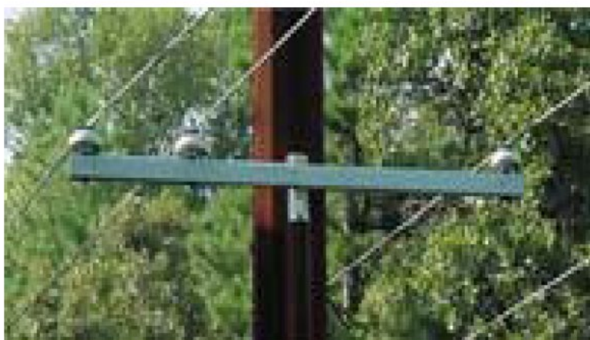
شکل ۵- تصویر کراس آرم کامپوزیتی [۸]
